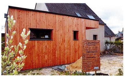
À Mellac, cette extension réalisée sur une ossature bois met en oeuvre du douglas, une isolation en ouate de cellulose et un bardage bois.
